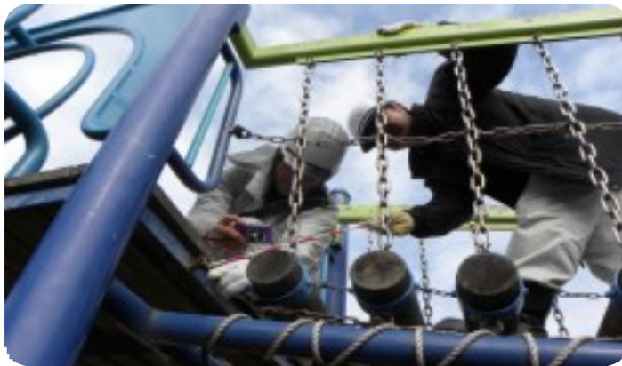
フランクの摩耗、止め金具を点検・確認する中村辰史職員(写真左)と平田嗣沙職員
